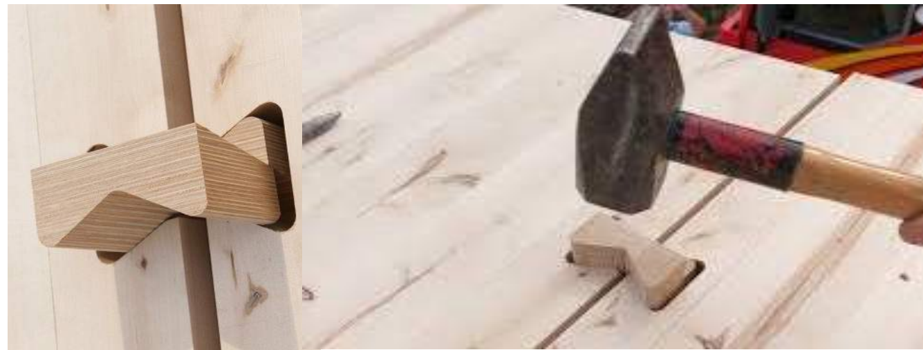
Tre - treforbindelser mellom massivtreplatene (for eks. X-Fix)
